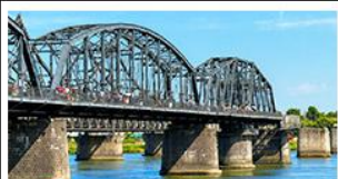
สะพานหวาดถานตง
