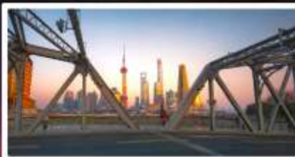
สะพานไวไป่ตู้
